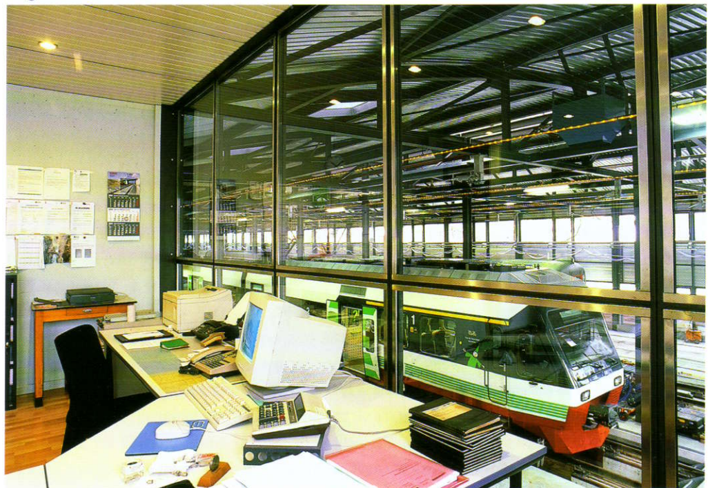
«Chauffage au sol» pour le bureau mais aussi pour les grandes halles: nouveau dépôt TRN, à Fleurier
