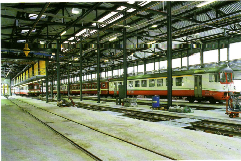
Sol thermoactif dans le dépôt ferroviaire, associé à des générateurs d'air chaud
