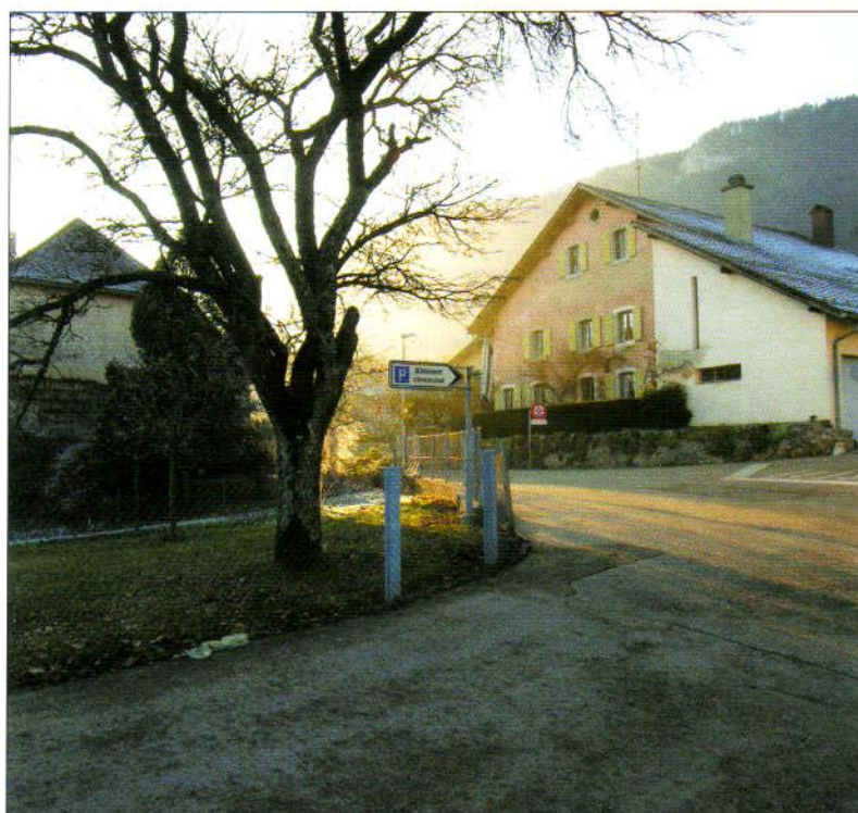
Maisons privées raccordées au réseau.
