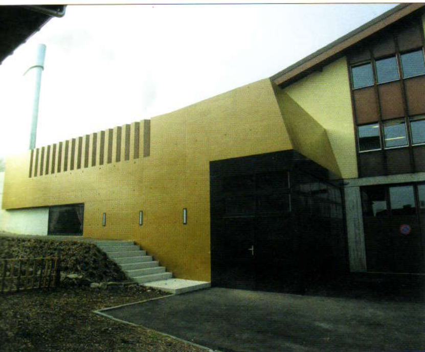
La nouvelle chaufferie est annexée au bâtiment communal. La construction comprend un garage pour les véhicules d’entretien de la voirie.
